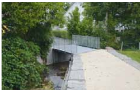
Hochwasserschutz im Metzgergässli.
