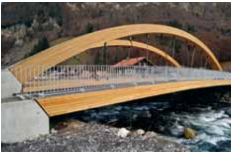
Brücke in Muotathal.
