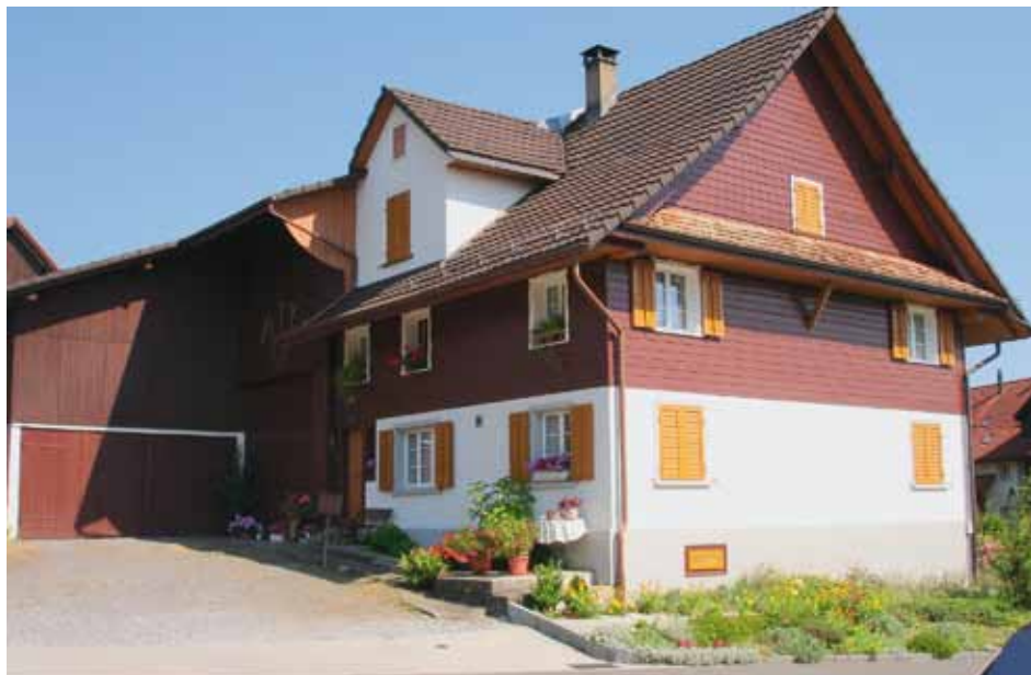
Das Spezielle am Kellerheiri-Hus ist die Holzverkleidung im Obergeschoss.
