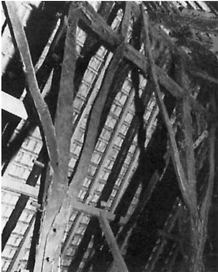
Dachgebälk mit Hochstüde.
