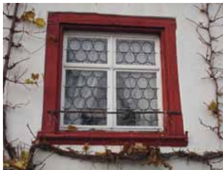
Einige Fenster am Riegelhaus sind noch in der alten Putzenverglasung erhalten.
