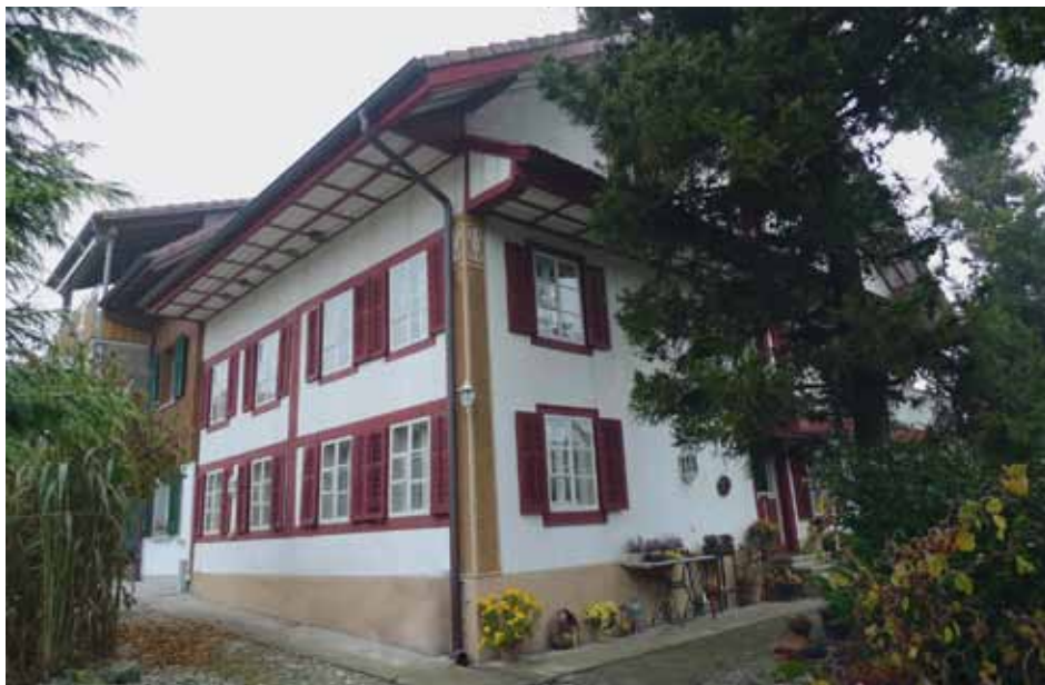
Das Grosse-Hus wurde über Jahrzehnte als Zweifamilienhaus benutzt.
