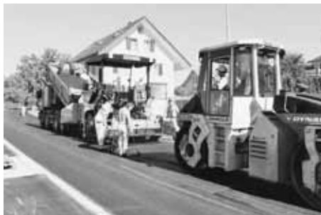
Die Bauarbeiten zur Sanierung der Bahnhofstrasse laufen auf Hochtouren.
