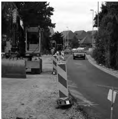
Die Bauarbeiten zur Sanierung der Bahnhofstrasse laufen auf Hochtouren.
